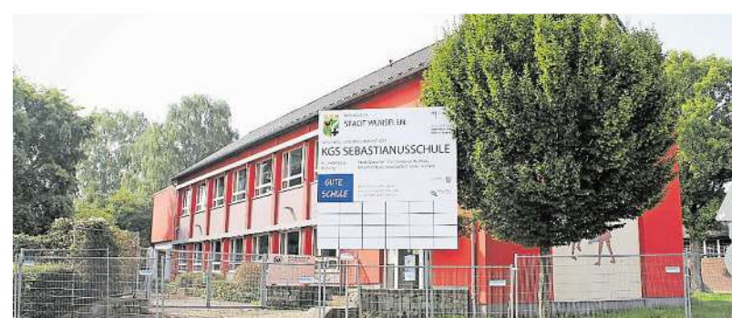
Altes Gebäude, altes Dach: Für den Erweiterungsbau der Sebastianusschule mit Flachdach hat die Stadt Würselen zeitgemäße Pläne.
